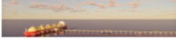
LNG IMPORT TERMINAL
